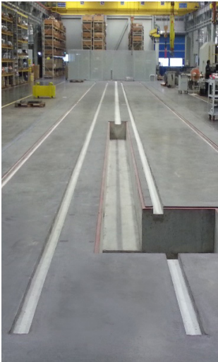
Installationsgrube für den Taktantrieb
